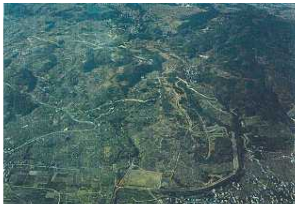
対策後の地すべり全景（昭和 60 年）
