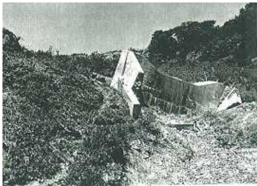
地すべりにより被災した谷止工 (昭和 16 年 6 月)
