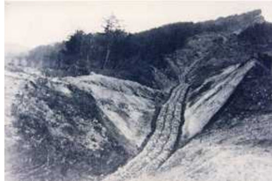
蛇籠水路工施工状況
