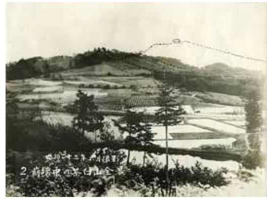
崩壊後の茶臼山全景（昭和23年6月） 破線が崩壊によりなくなった南峯
