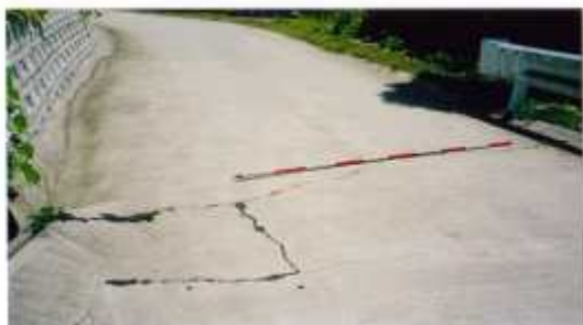
路面の亀裂
